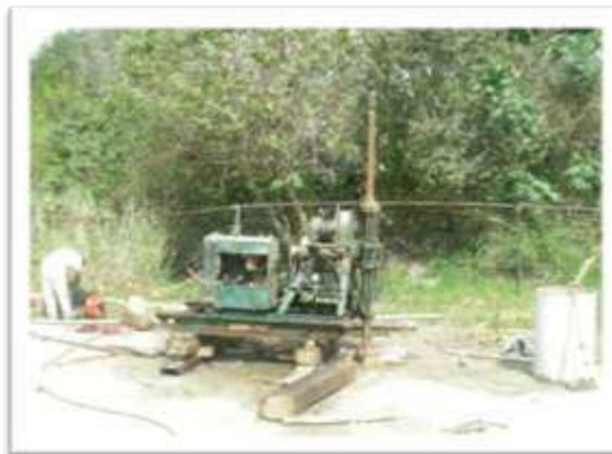
Equipo de perforación geotécnica. Realiza el ensayo de SPT ULA.
